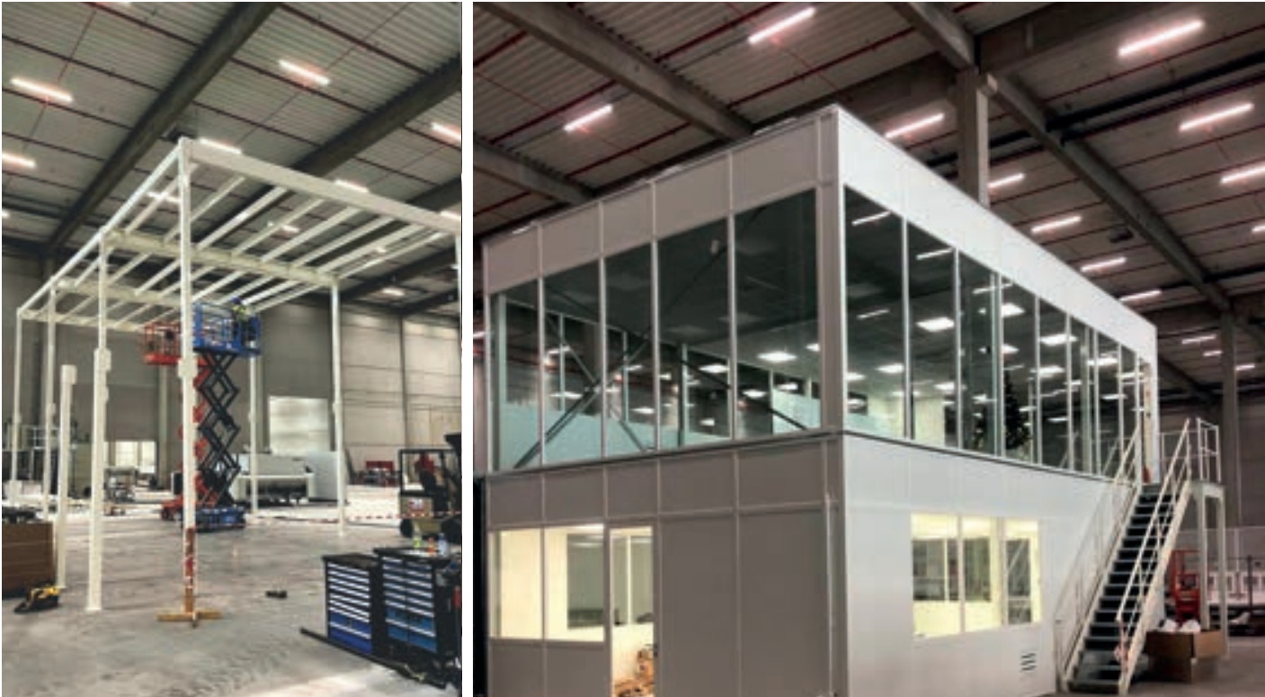
Een mezzanine met een draagcapaciteit van 1000 kg/m 2 optimaliseert ruimte-efficiëntie in magazijnen en fabrieken. Deze oplossing biedt extra werk- of opslagruimte boven bestaande vloerniveaus en ondersteunt zware lasten zonder problemen. De mezzanine kan bovendien ook ingezet worden als kantoorruimte, zoals hier afgebeeld.
